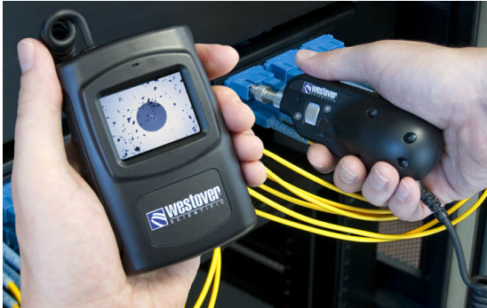
Inspektion eines Glasfaser-Patchfelds mittels Probe-Mikroskop
